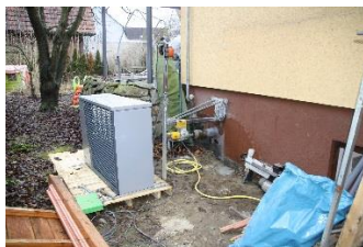
Abbildung 15 Montage der Luft-Wasser-Wärmepumpe (PW)
