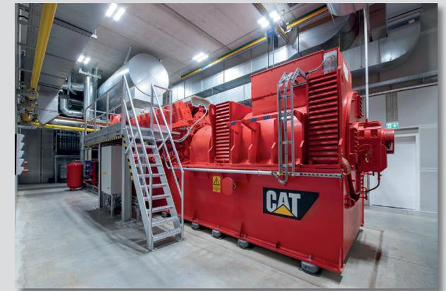
3 Module wurden im Juni 2018 eingebaut, Gewicht jeweils 54 Tonnen, je 16 Zylinder mit einer elektrischen Leistung von 4.300 Kilowatt. Dies entspricht rund 5.800 PS.
