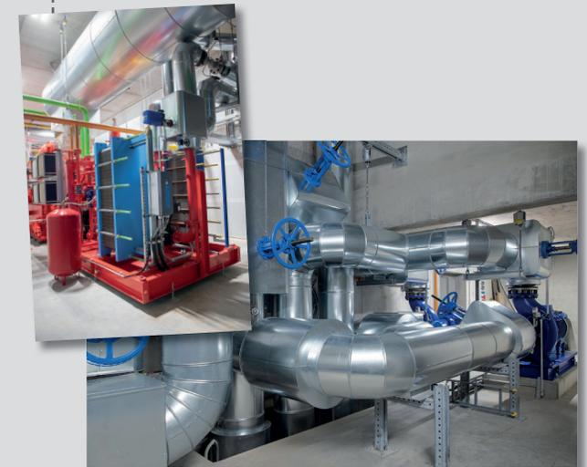
Die Plattenwärmetauscher wandeln die Hälfte der BHKW-Abwärme in Niedertemperaturwärme um. Das komplette Heizwasser wird in der Übergabestation an das Fernwärmenetz übergeben.
